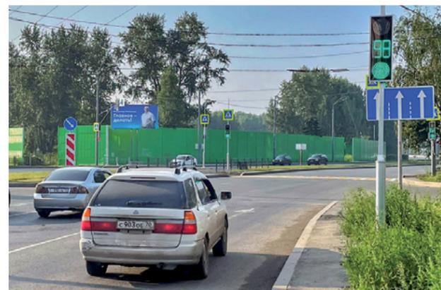
К работам на объекте подрядчик администрации приступил в конце июля. Рабочие проложили кабели, установили стойки для светофоров, заасфальтировали подход к пешеходному переходу со стороны пл. Южной и островок безопасности, выполнили дорожную разметку.
